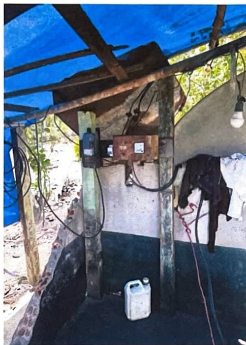
Figura 1 – Painel de controle do motogerador atual, em condições de exposição, na Vila Totó.
